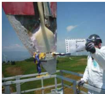
LIBI設置工事
